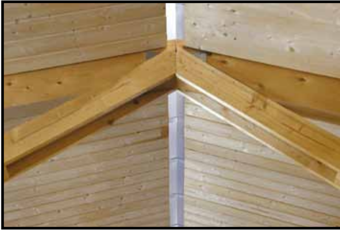
Molemmat kuvat ovat hevostallin painovoimaisen ilmanvaihdon harjatuuletuksesta. Jopa viime talven -30 °C pakkasilla tallin lämpötila oli pysynyt alimmillaan kahden plusasteen puolella. Tallissa on 21 karsinaa. Kuva vasemmalla rakennuksen sisältä ja oikealla ulkoa.
