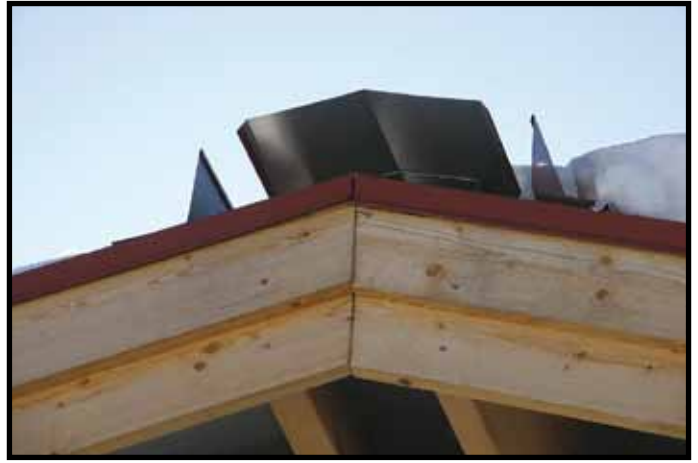
Molemmat kuvat ovat hevostallin painovoimaisen ilmanvaihdon harjatuuletuksesta. Jopa viime talven -30 °C pakkasilla tallin lämpötila oli pysynyt alimmillaan kahden plusasteen puolella. Tallissa on 21 karsinaa. Kuva vasemmalla rakennuksen sisältä ja oikealla ulkoa.
