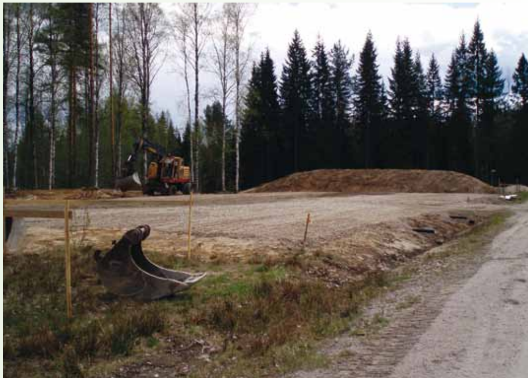
Yllä: Kentän riittävän hyvän kantavuuden takaavat esimerkiksi murske tai hyvä kalliosepele.
